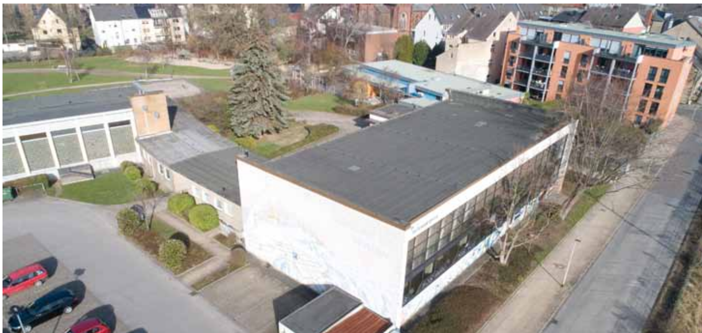
Das (alte) Annener Hallenbad ist bald Geschichte. Stadtspitze und Stadtwerkespitze verkündeten jetzt den Beginn der Abrucharbeiten. (Archivbild Olaf Gellisch)
