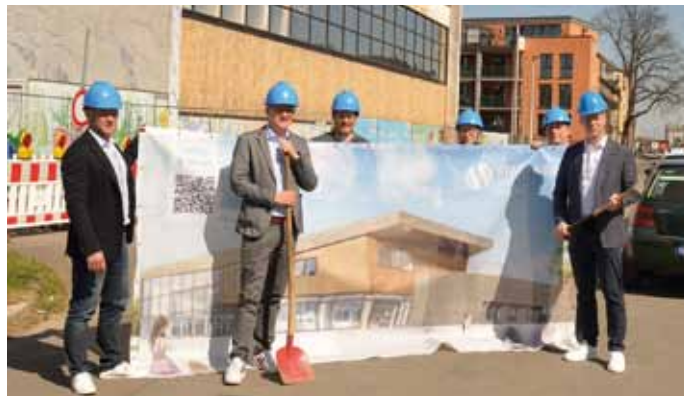
Bürgermeister Lars König (rechts) und Stadtwerke-Chef Andreas Schumski (2. von links) freuen sich gemeinsam mit Mitarbeitern über den Abriss des alten Hallenbades, das für ein neues, größeres und moderneres Hallenbad Platz machen soll.
