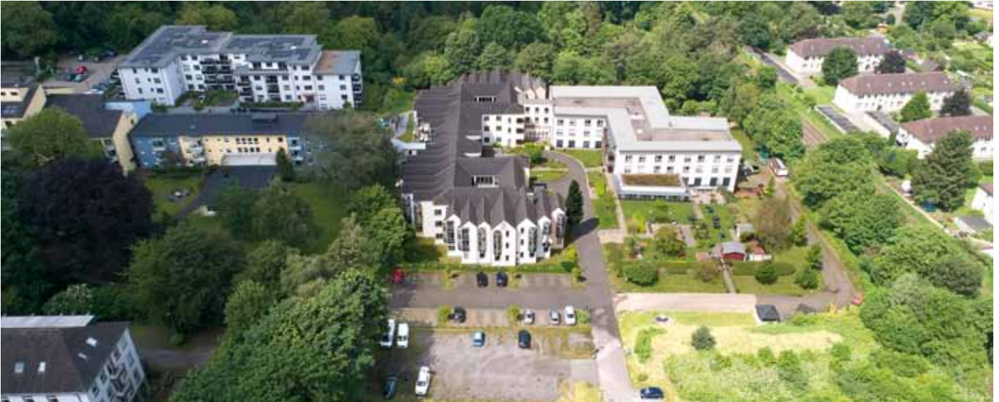
Das Altenzentrum am Schwesternpark / Feierabendhäuser aus der Vogelperspektive. (Archivbild)
